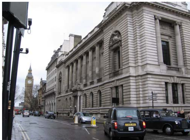
写真 5.27 イギリス土木学会外観(2階が図書館、地下がアーカイブ)
