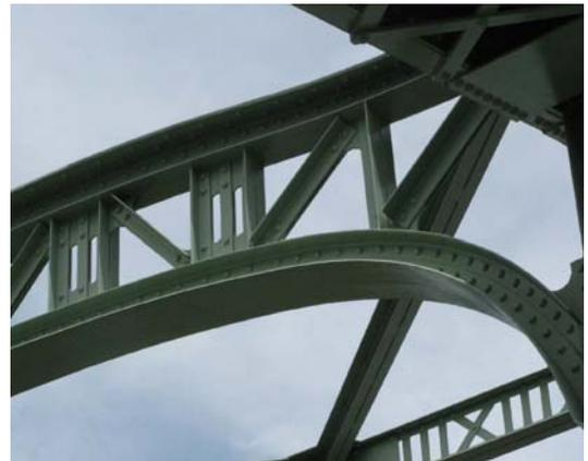
写真 4.20 尾張大橋橋門構造ポータル
