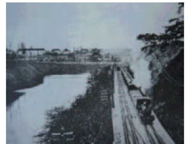
四谷駅付近を走る甲武鉄道 (「よみがえる四谷見附橋」土木学会 1993)
