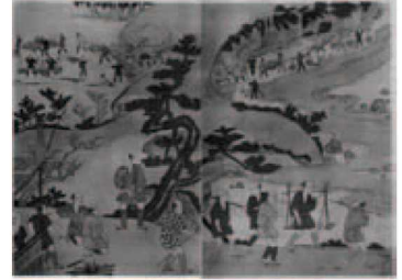
土工(眠江書帖『明治以前日本土木史』土木学会1936)
