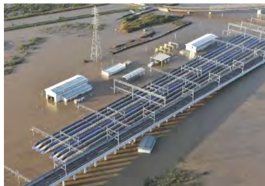
図1 2019年台風19号による長野新幹線車両センターの浸水状況
