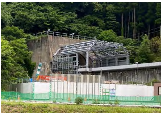
図-4 新設工事途中の吸音型緩衝工
