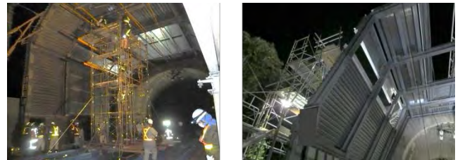
図-3 旧来の施工(左)と新工法(右)の様子
