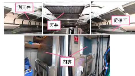
図 2 E956 形 4 号車客室の内装材の様子
