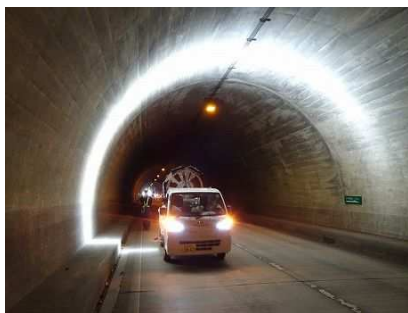
図-3.4 トンネルの撮影状況を示す。
