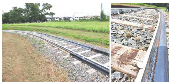
図 2 千葉実験線 2 における軌道上塗装の例 (基本状態)
