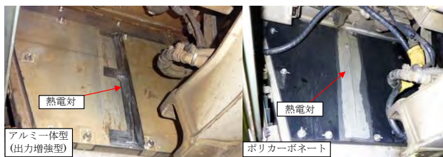
図 4 ヒータ付き台車端部フサギ板の仮設状況
