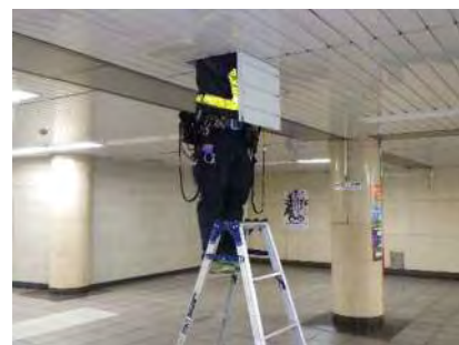
図 2 検査状況 (点検口からの目視)
