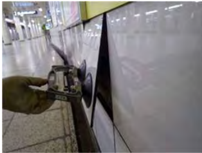
図 3 検査状況 (吸盤による引っ張り)
