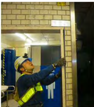
図 5 検査状況 (三方枠ゆらし)
