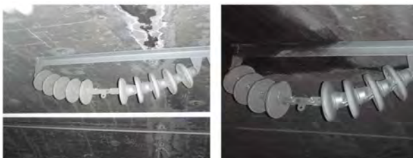
Fig.3. トンネル内無加圧暴露試験の架設状況 (左：トンネル坑口箇所 右：トンネル内部)
