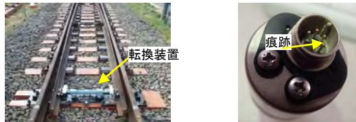
(a) 転換試験の様子 (b) 圧力計のコネクタ部
