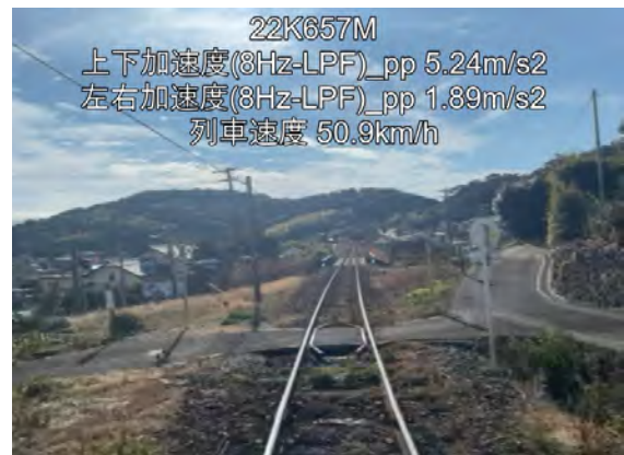
(a) 例 1 (22K650M 付近, 踏切箇所)
