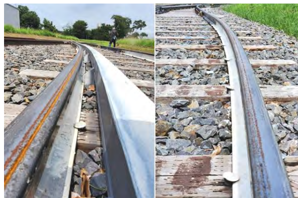
図 3 千葉試験線 2 のレール上における走行痕の例
