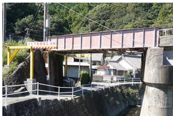
図 1 橋りょう外観
