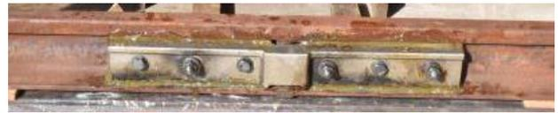
図8 テルミット溶接部用接着継目
