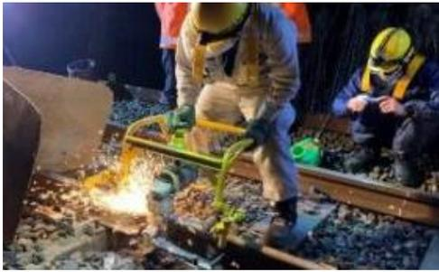
図5 レール溶接部研磨装置による仕上げ作業
