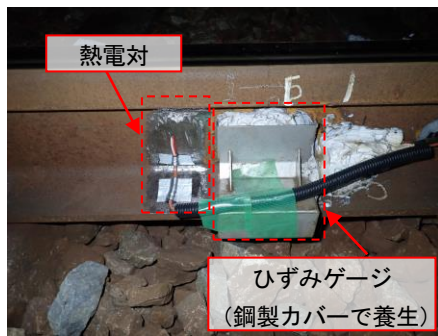
図4 ひずみゲージ・熱電対の貼付け状況（測点 e）
