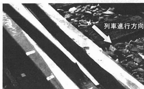
図1 圧接クロッシング乗移り部の外観
