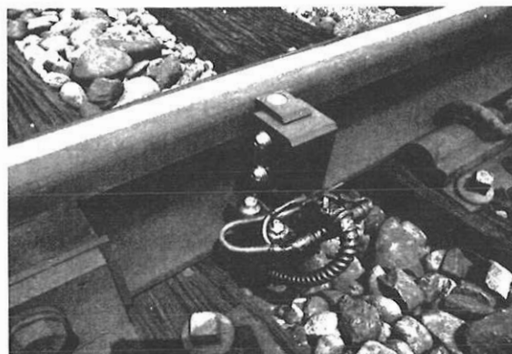
図4：車輪センサ設置状況
