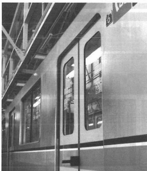
写真3 戸挟み再現試験 (車側灯：滅、戸挟み検知状態)
