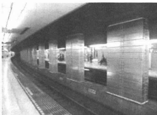
写真2 工事完了状況
