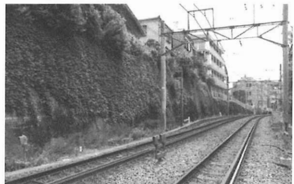
写真 1 工事着工前全景
