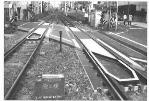
写真 3 接続軌道ブロック敷設後
