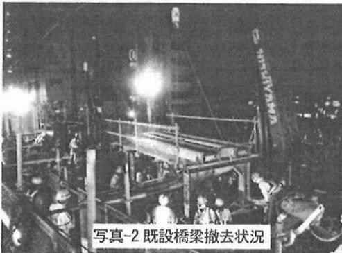
写真-2 既設橋梁撤去状況
