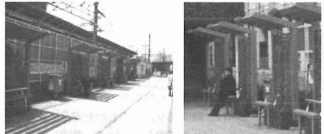
写真 12, 13 北口ロータリー歩道部
