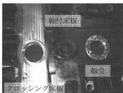
図5 転換軸部の部材
