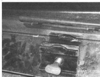
図8 固定レール底部と座金の形状
