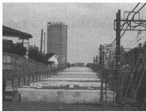
写真 2 気泡モルタル打設完了
