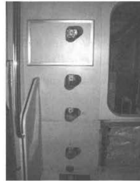
図 3 風圧孔設置状況
