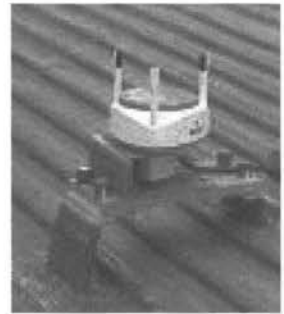
図 4 超音波風速計設置状況
