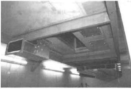
図 6 給気ダクト単体の接続状況
