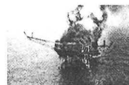
北海石油生産プラットフォーム パイパーアルファの火災事故 (死者167名・被害額3,400億)
