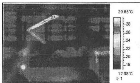
急速充電直後のパンタグラフ周辺温度分布
