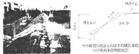
図.10 鉄道盛土の被害事例
