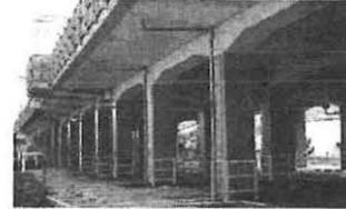
写真-4 RC高架橋の標準補強工法(鋼板巻き補強工法)
