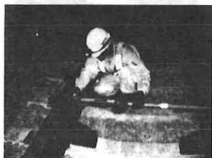
図 18 敷設後の状態確認
