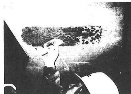
Fig.1 部分断面修復工法(左官工法)
