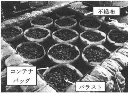
図 6 コンテナバッグの配置
