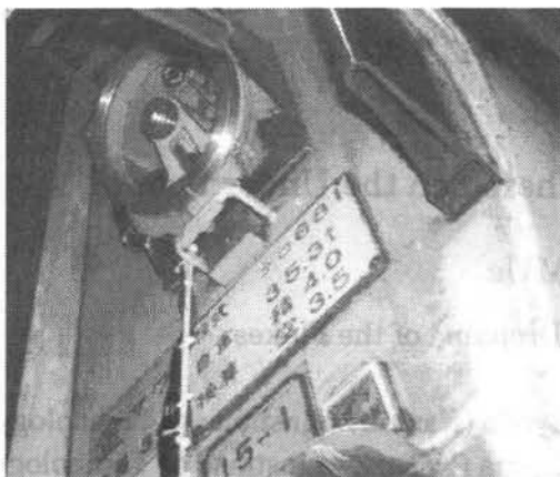
図1 CCDカメラを内蔵した旋回窓の取付状況
