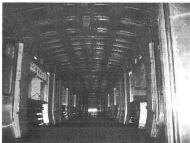
図2 吊手棒取付状況
