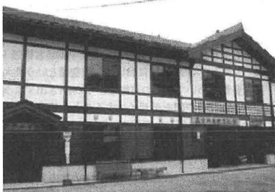
【写真-3】交流施設を合築した飯山線森宮野原駅 (2004 年 4 月オープン)
