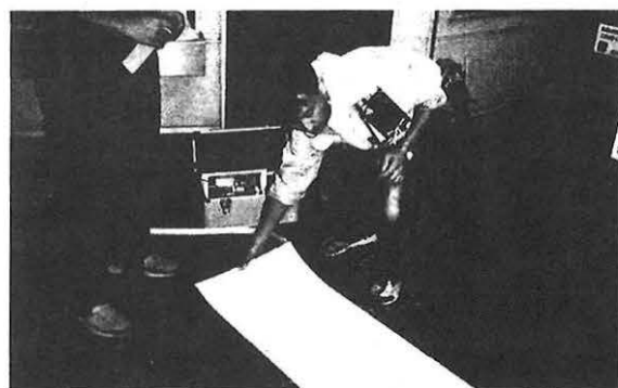
図7 タグアンテナの設置作業
