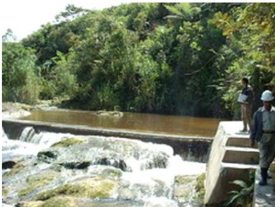
写真-9 既設灌漑取水設備（改修後）
