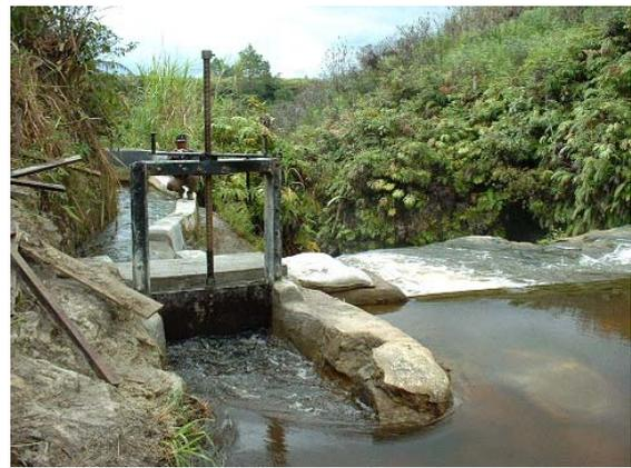
写真-5 灌漑取水口における流量調節施設の例
