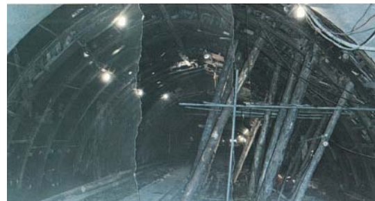
写真-1 支保工の補強状況 1)
