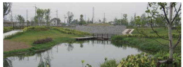
図-13 スケッチにもとづいて竣工した調整池
