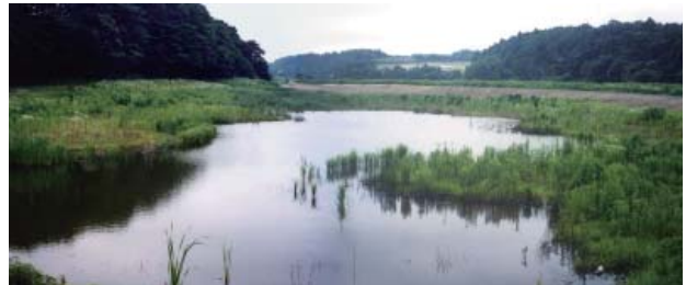
図-29 竣工後の多自然型調整池
