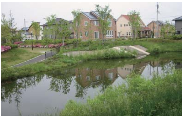
図-20 住宅地が隣接する調整池
