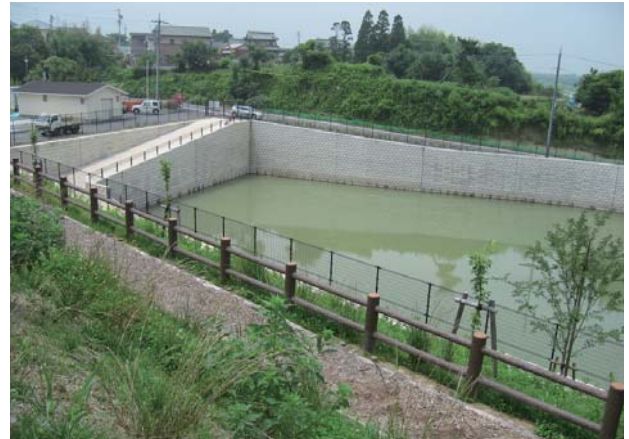
図-4 周辺景観と調和しない調整池
