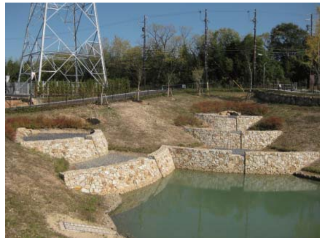
図-35 多段式ろ過池を導入した調整池
