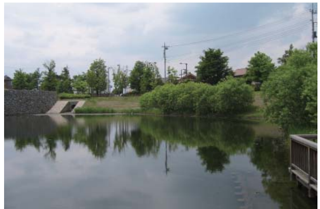
図-17 水位と水質が安定している調整池
