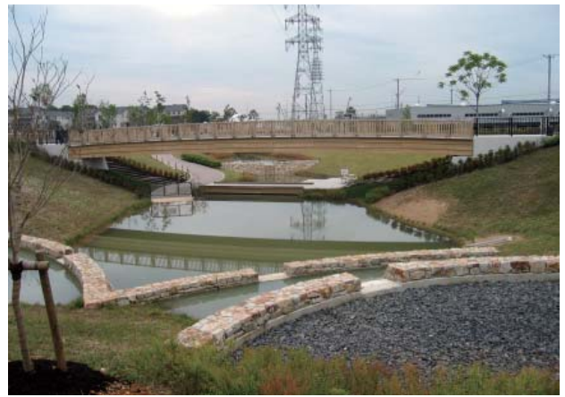
図-34 景観検討に基づいた調整池
