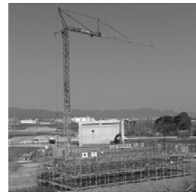
図-1 ジブクレーンの例
