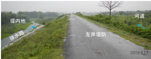
図-3 コシ河では河床が堤内地盤高より高くなっている
