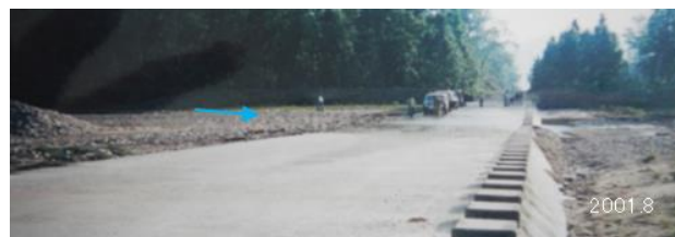
図-8 洪水の越流を前提としたシンズリ道路のコースウエー
