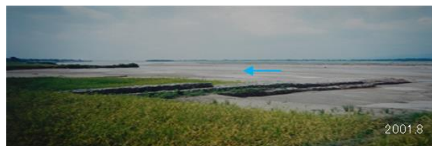
図-9 ラカンディ川沿いに設置された鉄線籠水制
