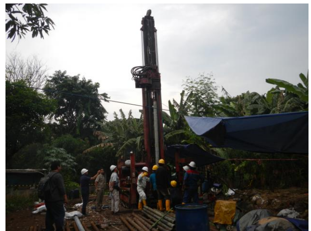
図-5 結束されたスライド管と外管の建て込み
