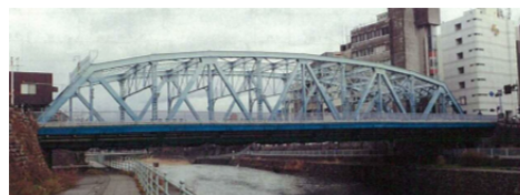
写真-3 犀川大橋
