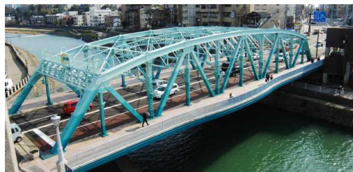
写真-1 犀川大橋
