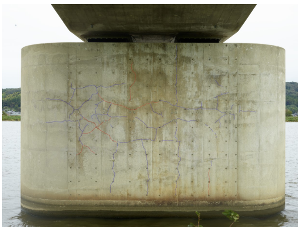
図-6 近接目視点検結果から作成した解答データ
