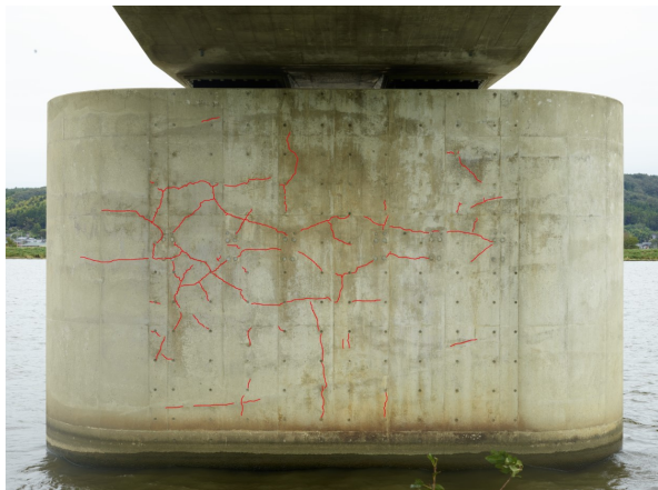
図-4 ひび割れ検出結果の一例
